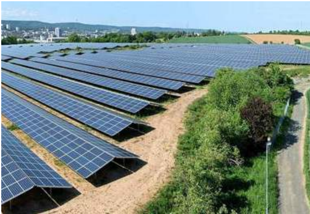
Dakjesopstelling: geen gecombineerd landgebruik mogelijk
