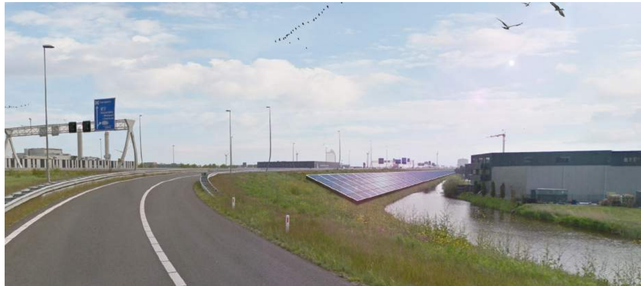
Figuur 3.4 Zonnepanelen op een talud (beeld studie Feddes/Olthof voor de A10 en Westrandweg in Amsterdam)
